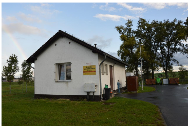
Obrázek 21. Čistírna odpadních vod
