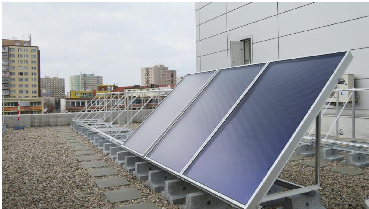
Obrázek 14. Solární panely sloužící pro vytápění AQUACENTRA
