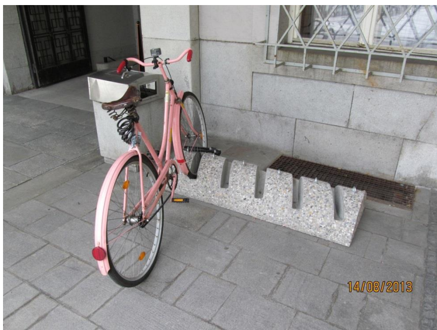
Obrázek 2 – Nová radnice, Moravská Ostrava – ke stojanu lze uzamknout bohužel pouze přední, popř. zadní kolo, konstrukce může ničit ráfky a výplet jízdních kol, které jsou ve stojanu málo stabilní.
