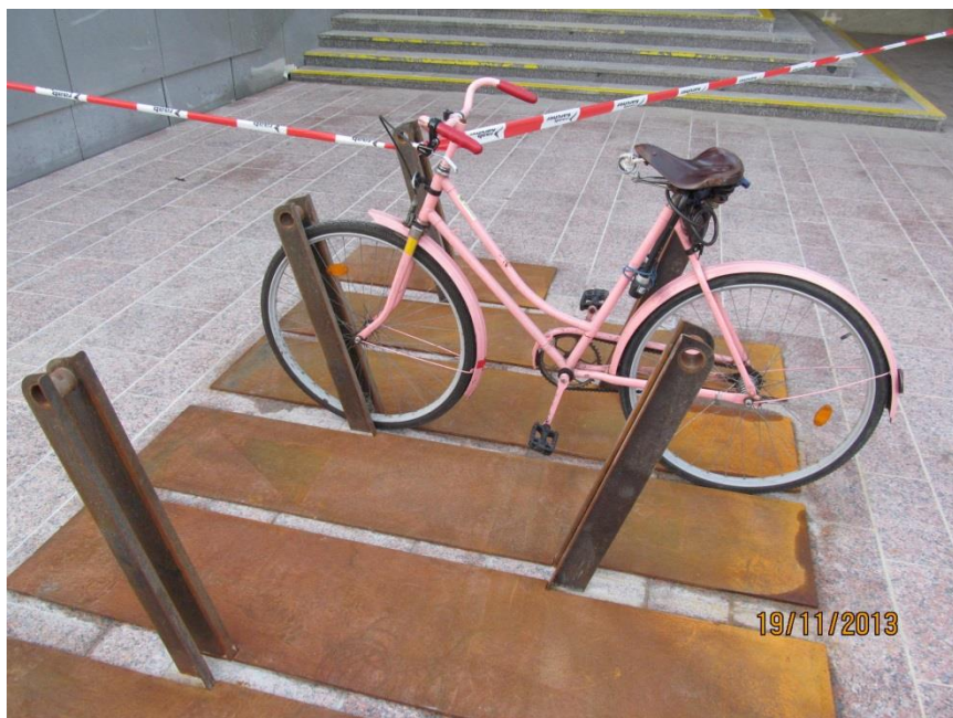
Obrázek 3 – Ostrava-hl. nádr., Přívoz – ke stojanu lze uzamknout bohužel pouze přední, popř. zadní kolo, konstrukce může ničit ráfky, výplet či kotoučové brzdy jízdních kol, které jsou ve stojanu málo stabilní.
