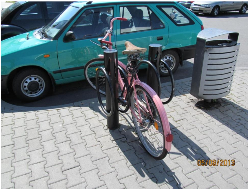
Obrázek 4 – OC Futurum, Mariánské Hory – vhodný atypický pevný stojan, bohužel nedostatečně vzdálený od parkovacího stání a vedle stojícího dalšího stojanu. Při dnešních intenzitách parkujících jízdních kol dostačující.
