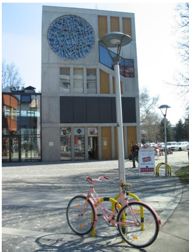
Obrázek 7 – Divadlo loutek, Moravská Ostrava – alternativní použití pevných ale bohužel nízkých zábran proti najetí do sloupů veřejného osvětlení.
