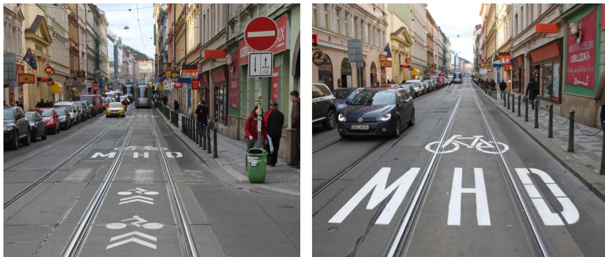
Prostřední pruh pro jízdní kola a vozidla veřejné dopravy – tramvaje a autobusy (Praha, Lidická)
