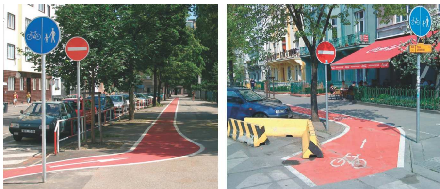
Ukázka protisměrného vjezdu do cykloobousměrky provedené pomocí oddělené stezky mimo vozovku (Praha, Ortenovo náměstí a Ověnecká; pozn.: chybně vysunutý cityblok, chybějící hmatný pás)
